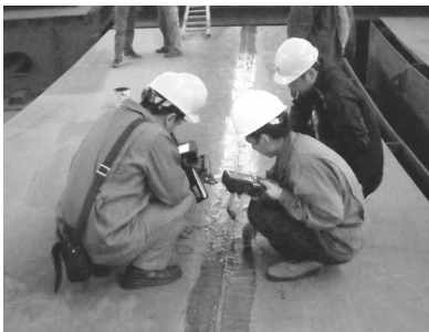
图 6-6 焊缝探伤检测
